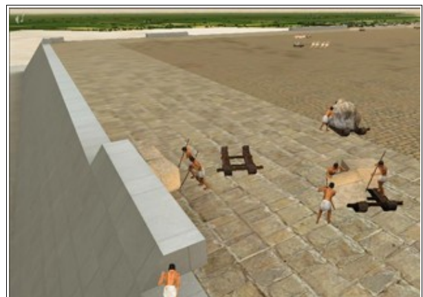
La pose des blocs de parement (c) Dassault Systèmes
